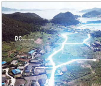
서거차도 DC Microgrid System
